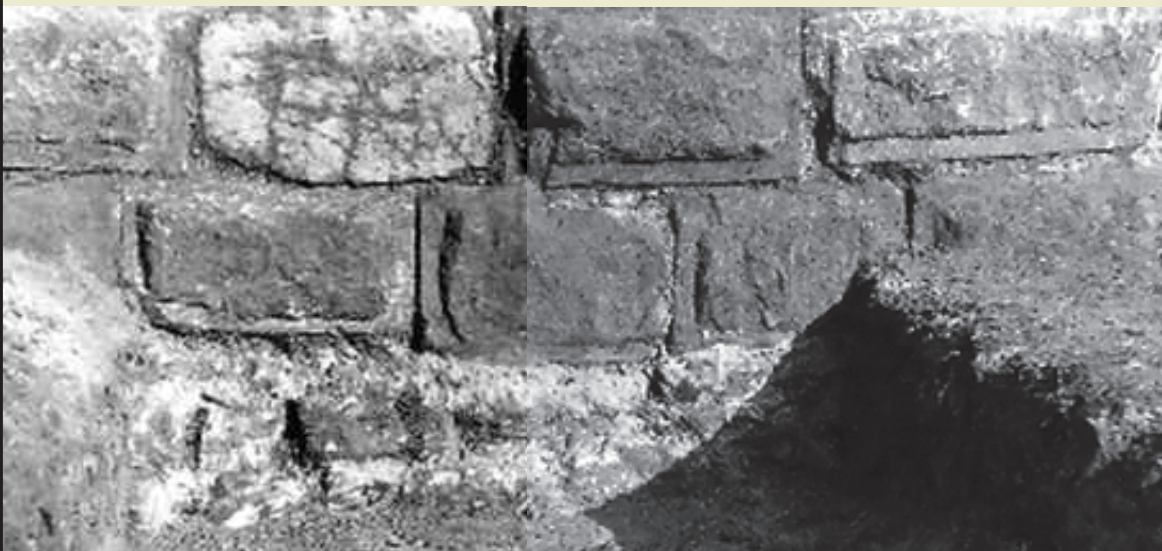
Detail Mauerwerk: Von der Burg aus der Mitte des 12. Jahrhunderts, die auf einer von der Nidda und einem Seitenarm gebildeten Insel erbaut wurde, sind Teile einer Ringmauer mit Buckelquaderverblendung erhalten.
