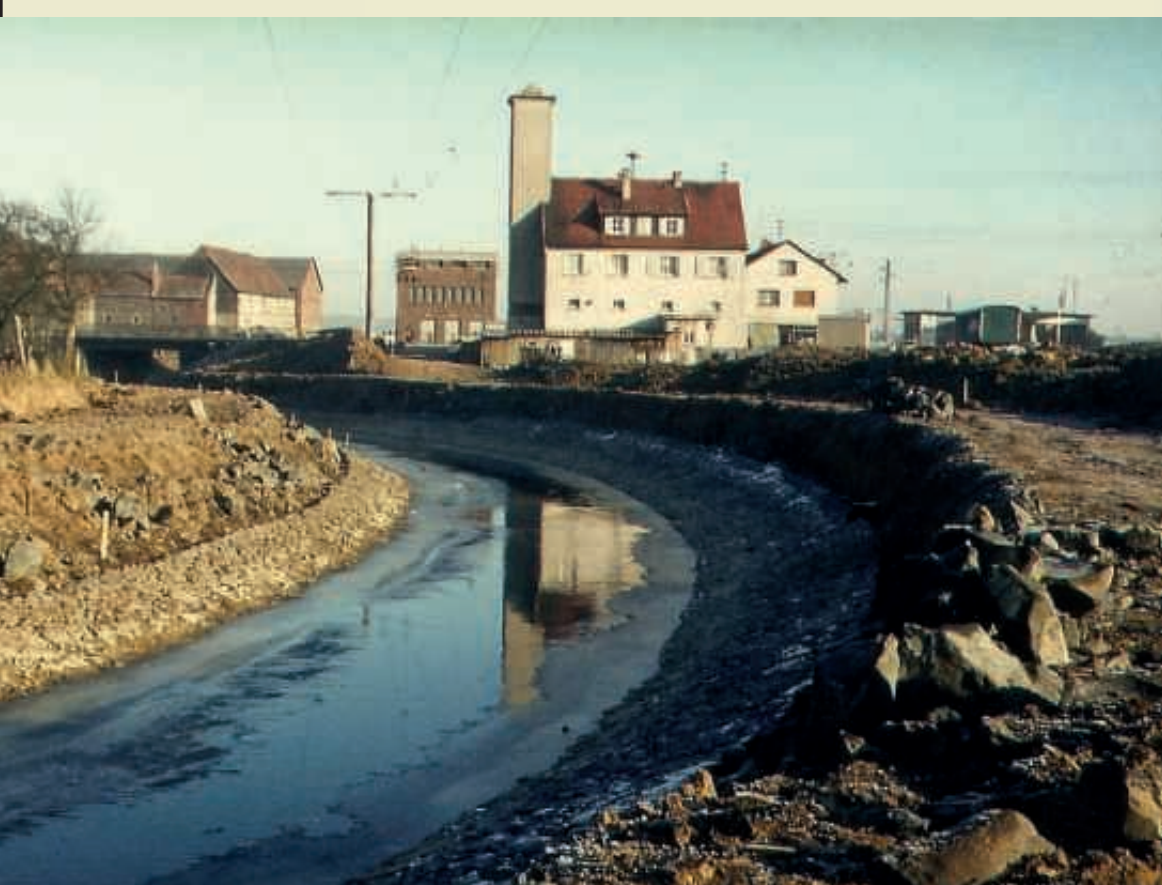
Bei der Niddaregulierung 1970 wurde der Flusslauf begradigt und die Fließgeschwindigkeit erhöht.
